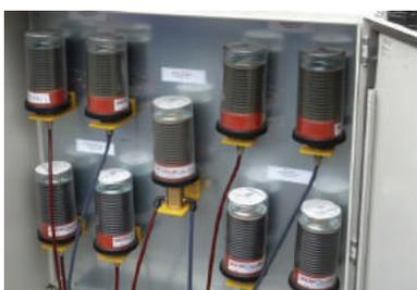
Trattamento rifiuti alimentari: cabina di Memolub per la lubrificazione dei cuscinetti dei trasportatori di un fermentatore rotativo.
