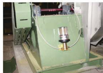
Industria alimentare: lubrificazione dei cuscinetti per ventilatore Solyvent Ventec.
